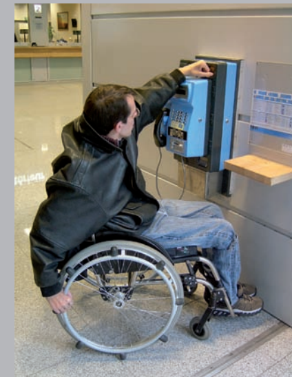
✓ Hauteur conforme des dispositifs à manipuler
