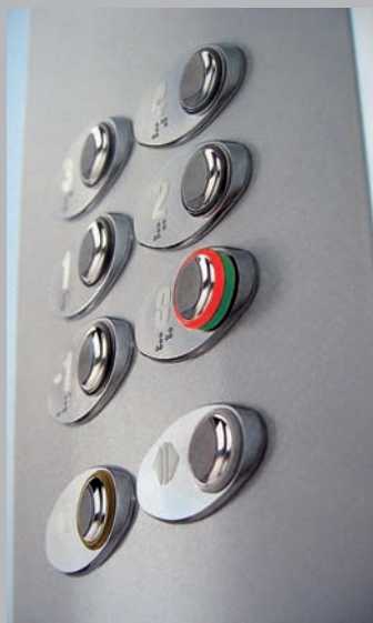
✓ Repères tactiles sur boutons d'ascenseurs
