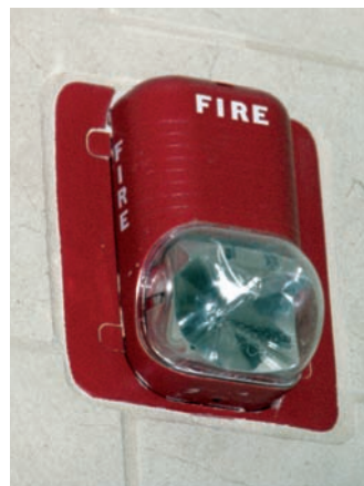
✓ Exemples d'une alarme incendie et de détecteurs de fumée avec flash lumineux
