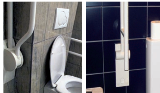
✔ Sabot de fixation hors de la zone de transfert
