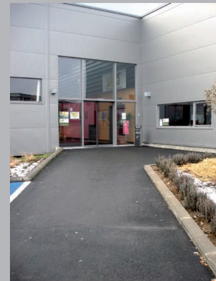
✓ Voie d'accès de largeur suffisante.
