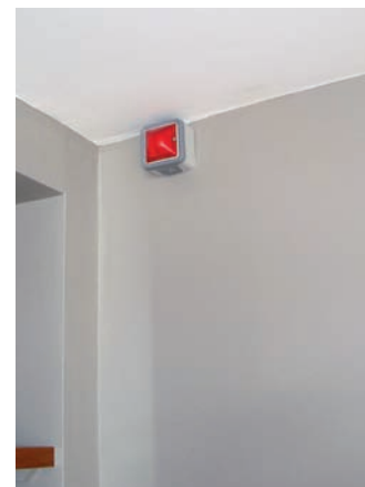
✓ Exemples d'une alarme incendie et de détecteurs de fumée avec flash lumineux
