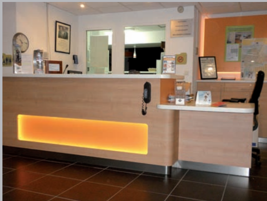
✗ Tablette surbaissée trop peu profonde
