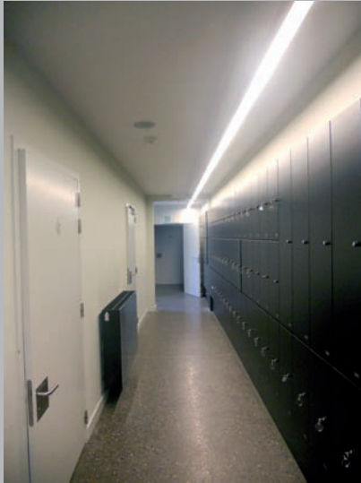
✓ Eclairage servant de ligne guide
